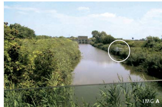
QUI SOPRA: Opera di presa del Canale Montalbano (IMG A) IN ALTO: Un tratto del Canale Novissimo prima dei lavori
