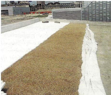
Foto 1 - Fase di cantiere: si notano i diversi strati drenanti e di accumulo idrico utilizzati, e il tessuto non tessuto posto a copertura.
